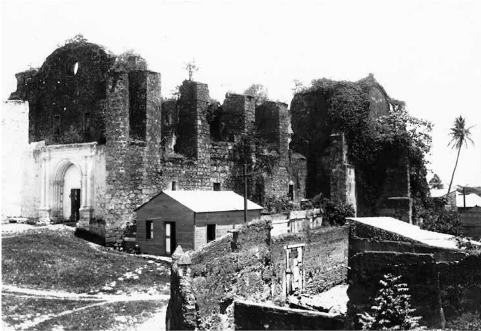
Ruinas del convento de San Francisco antes de 1920.
